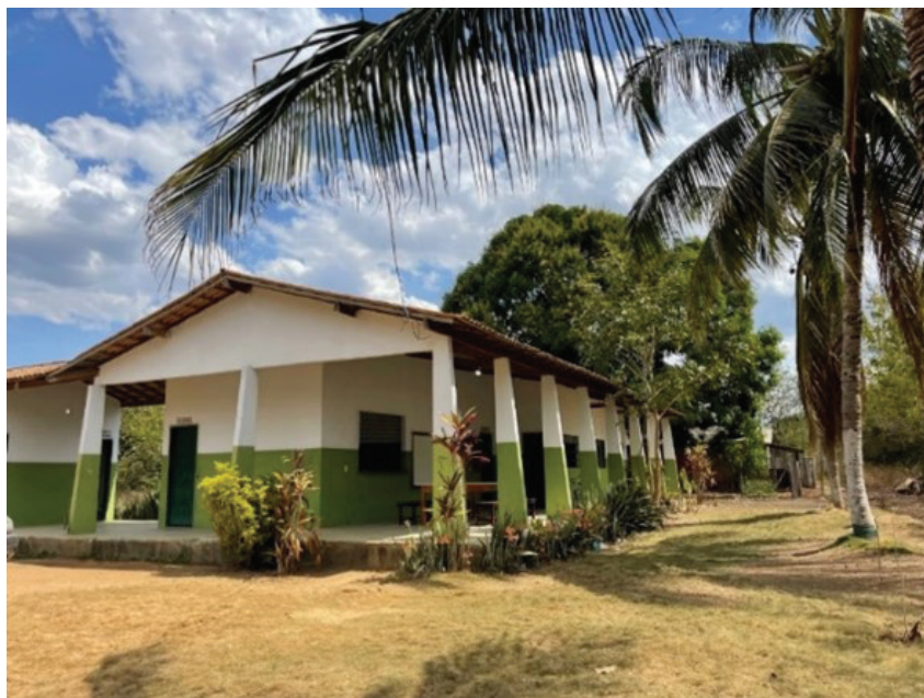
Figura 2 – Escola da comunidade PA Goiano Fonte: Ambiental Engenharia, 2023
