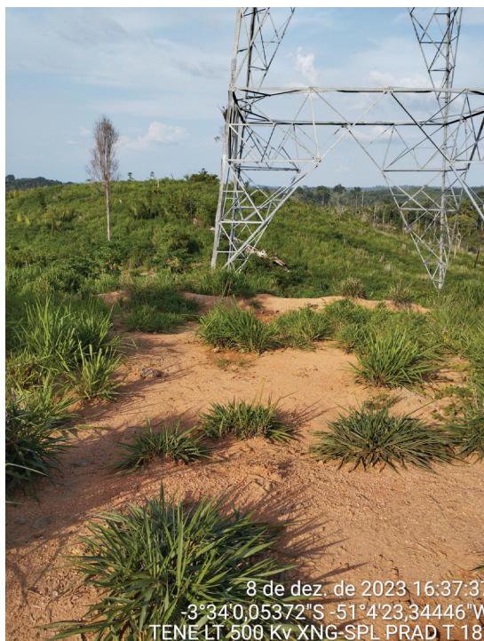
Figura 1 – Torre em área de declividade LT 500 kV Xingu-Serra Pelada Torre 181 - Fonte: Ambiental Engenharia, 2023
