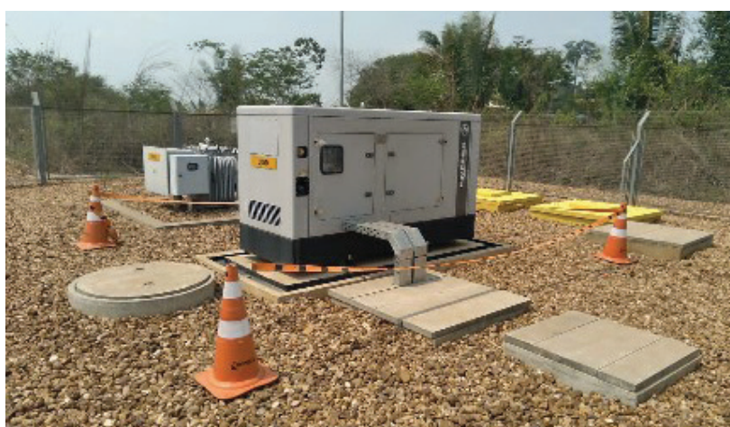
Figura 7- Caixa Separadora de Água e óleo (CSAO) na SE Itacaiúnas
