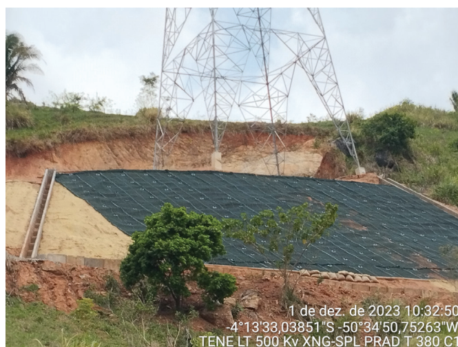
Figura 3 – Obra realizada em torre para contenção de erosão na LT 500kV Xingu - Serra Pelada torre 380 Fonte: Ambiental Engenharia, 2023
