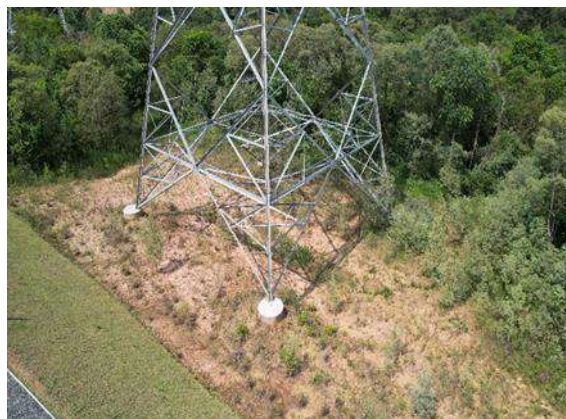
Figura 1.3.22. Vista da área AA 005 em processo de revegetação (setembro de 2023).
