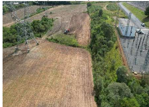
Figura 1.3.9. Vista da área utilizada como acesso as obras de ampliação da SE (setembro de 2023).
