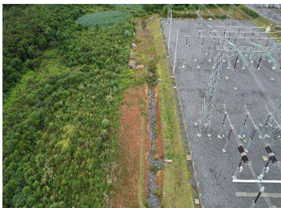
Figura 1.3.16. Dissipadores de energia e drenos em rocha implantados na área AA 004 (março de 2023).
