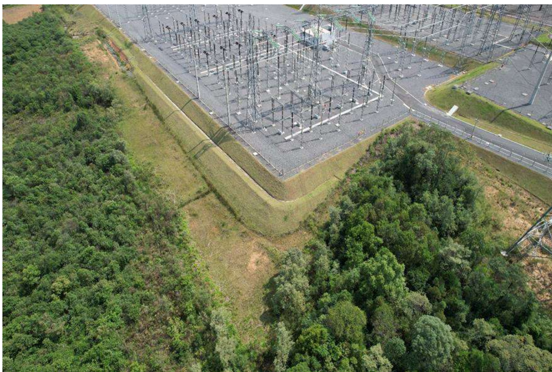
Figura 1.3.15. Vista aérea da Área Alvo 004.
