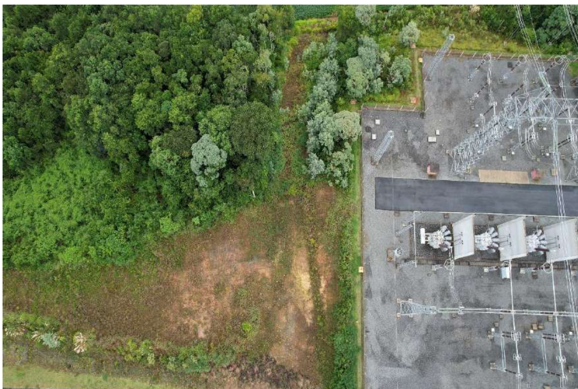
Figura 1.3.5. Vista aérea da Área Alvo 002.
