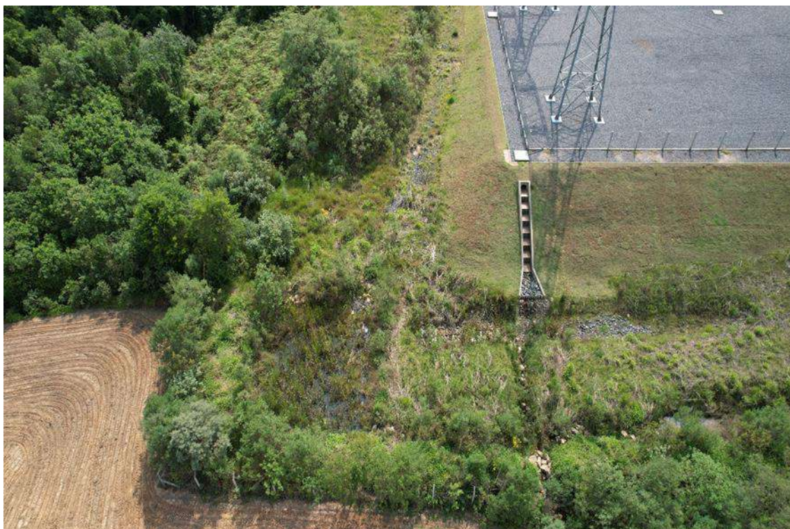
Figura 1.3.10. Vista aérea da Área Alvo 003.
