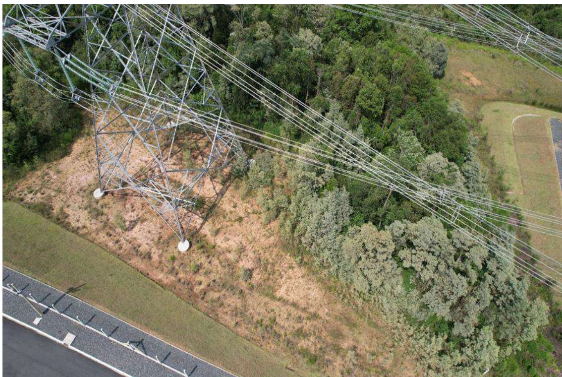
Figura 1.3.20. Vista aérea da Área Alvo 005.
