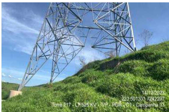
Figura 1.3.8. Cobertura vegetal com excelente taxa de ocupação da área (Torre 217).
