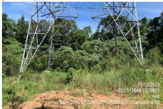
Figura 1.3.15. Área estável, livre de processos erosivos (Torre 261).
