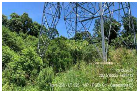
Figura 1.3.16. Cobertura vegetal com ótima taxa de ocupação (Torre 268).
