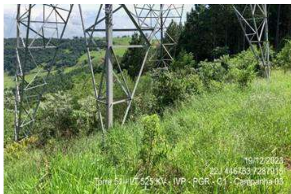
Figura 1.3.2. Cobertura vegetal com ótima taxa de desenvolvimento e ocupação da área (Torre 51).
