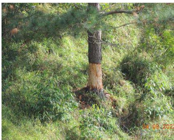
Figura 1.6.32. Detalhe do anelamento.
