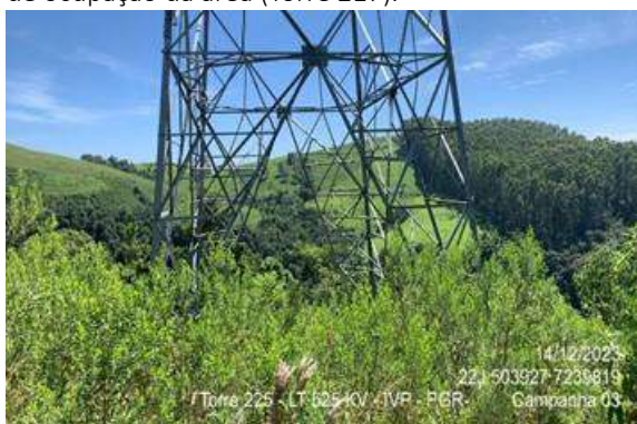
Figura 1.3.10. Área estável, livre de processos erosivos (Torre 225).
