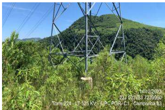
Figura 1.3.9. Área estável, livre de processos erosivos (Torre 224).
