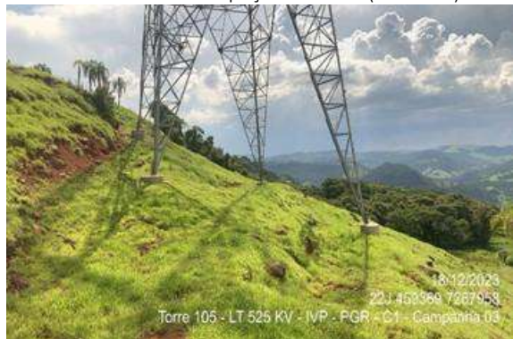
Figura 1.3.4. Área estável, livre de processos erosivos (Torre 105).
