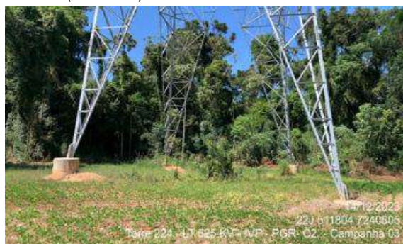
Figura 1.3.14. Área estável, livre de processos erosivos (Torre 224).
