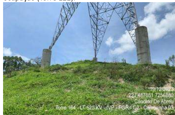
Figura 1.3.11. Cobertura vegetal com boa taxa de germinação, desenvolvimento e ocupação da área (Torre 164).
