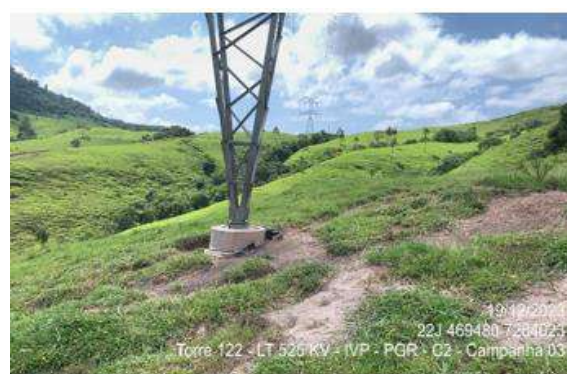
Figura 1.3.9. Cobertura vegetal apresentando avanço na taxa de germinação, desenvolvimento e ocupação (Torre 122).
