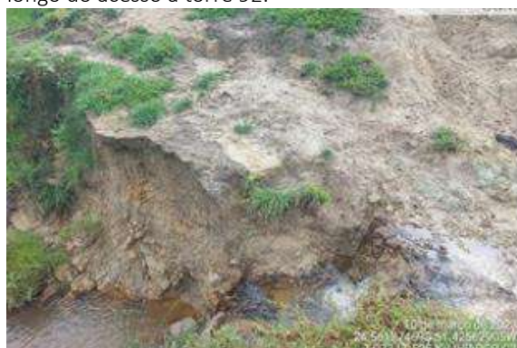
Figura 1.2.4. Processos erosivos no acesso à torre 73.
