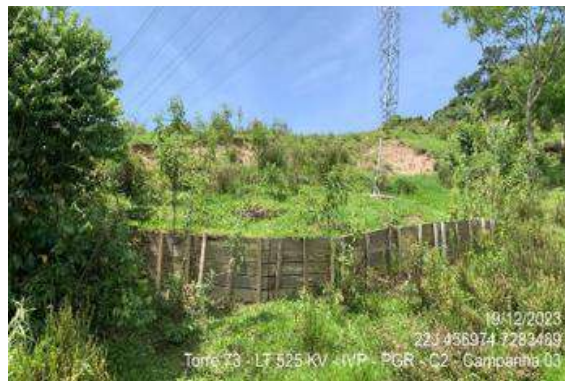
Figura 1.3.3. Paliçada firme e estruturada (Torre 73).
