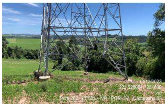
Figura 1.3.17. Área estável, livre de processos erosivos (Torre 267).
