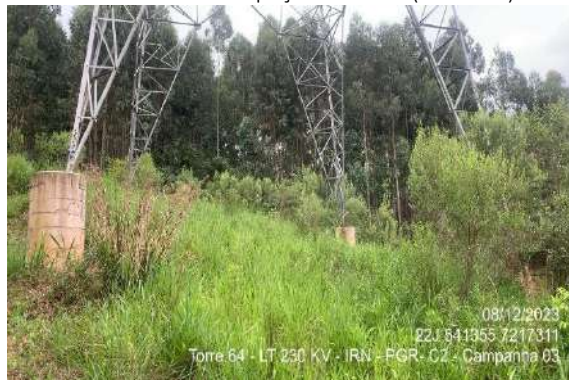
Figura 1.2.4. Área estável, livre de processos erosivos (Torre 64).
