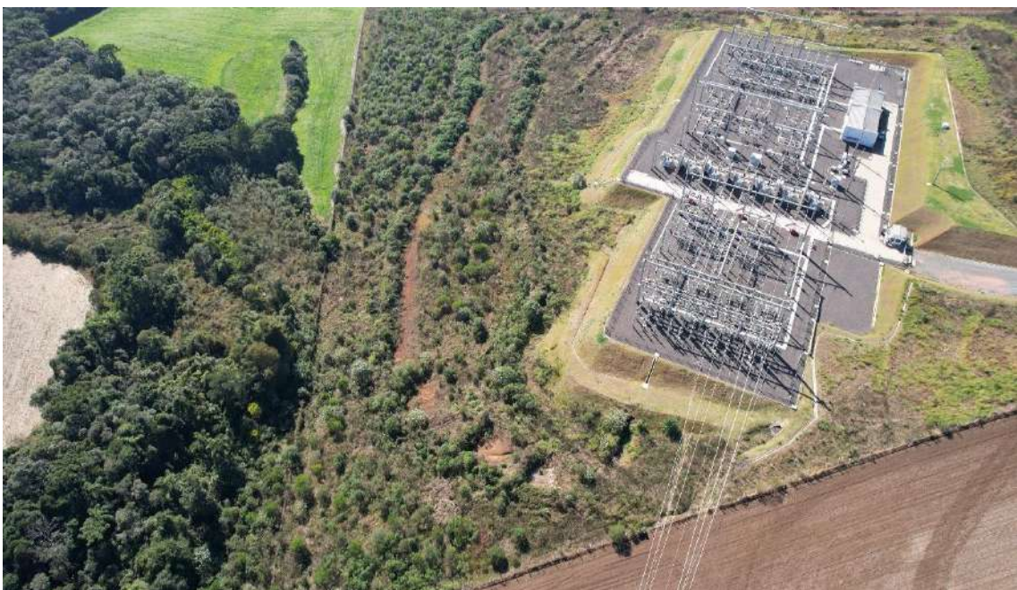
Figura 1.3.5. Vista aérea da Área Alvo 0002.
