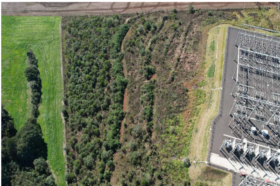
Figura 1.3.11. Vista aérea da Área Alvo 0004.
