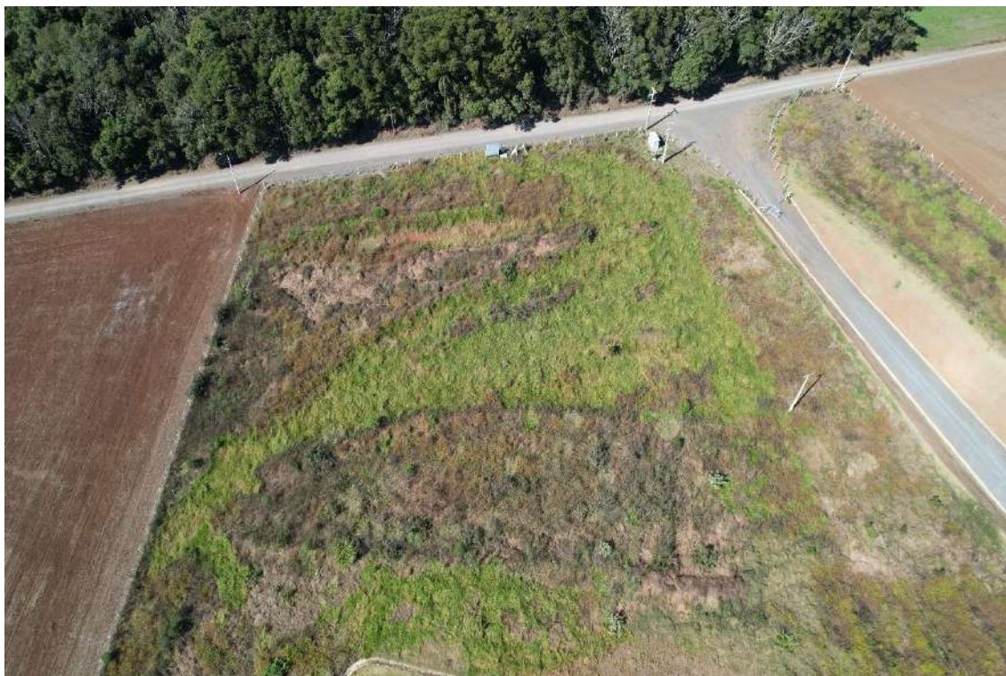
Figura 1.3.2. Vista aérea da Área Alvo 0001.
