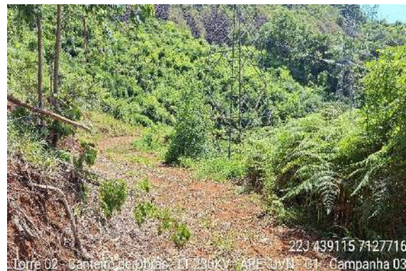
Figura 1.3.3. Extensão do acesso estável, livre de processos erosivos e acúmulos de água (acesso 02).
