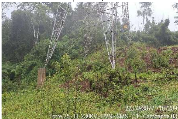
Figura 1.3.20. Cobertura vegetal em bom progresso de ocupação da área (torre 25).
