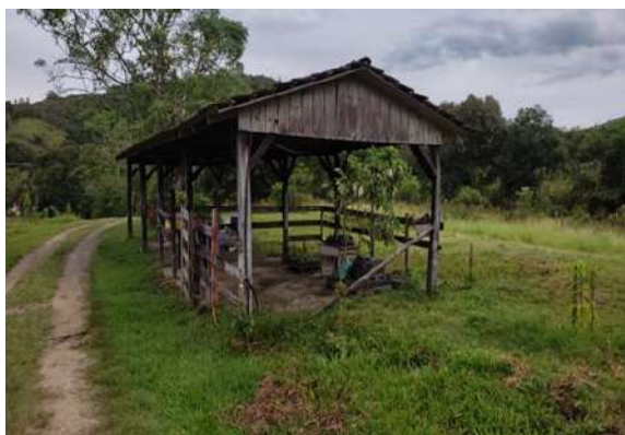
Figura 1.6.11. Estrutura de armazenamento das mudas até o momento do plantio.
