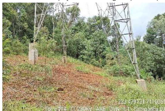
Figura 1.3.15. Área estável, livre de processos erosivos e associados (torre 114).
