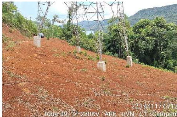
Figura 1.3.4. Dispositivos de drenagem contribuem significativamente para a contenção das ravinas (torre 09).
