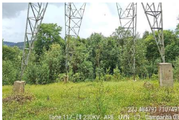
Figura 1.3.17. Cobertura vegetal apresenta boa taxa de germinação e ocupação da área (torre 117).
