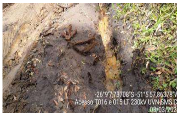
Figura 1.2.2. Princípio de processos erosivos em acessos às torres 15 e 16.
