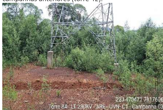
Figura 1.3.13. Cobertura vegetal com germinação, crescimento e ocupação da área irregular (torre 84).
