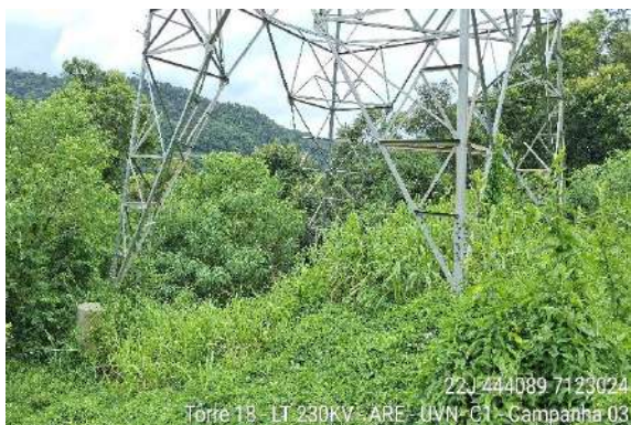
Figura 1.3.8. Área estável, livre de processos erosivos (torre 18).
