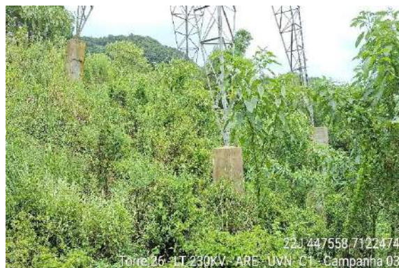
Figura 1.3.9. Cobertura vegetal com 90% de ocupação da área (torre 26).
