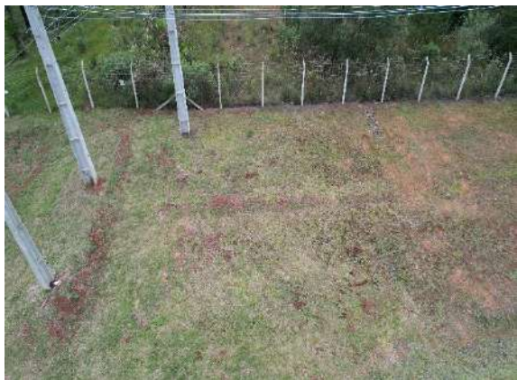
Figura 1.3.9. Vista da área AA 0003 (março de 2023).
