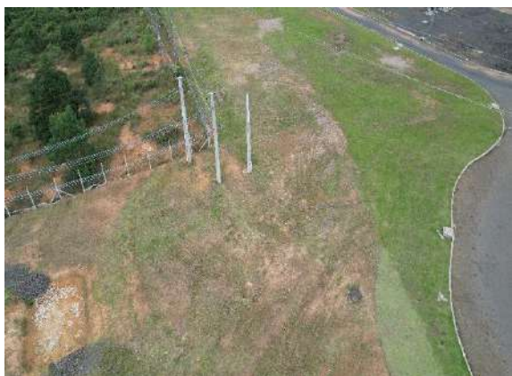
Figura 1.3.12. Vista do dispositivo de controle de processo erosivo da área AA 0004 (março de 2023).
