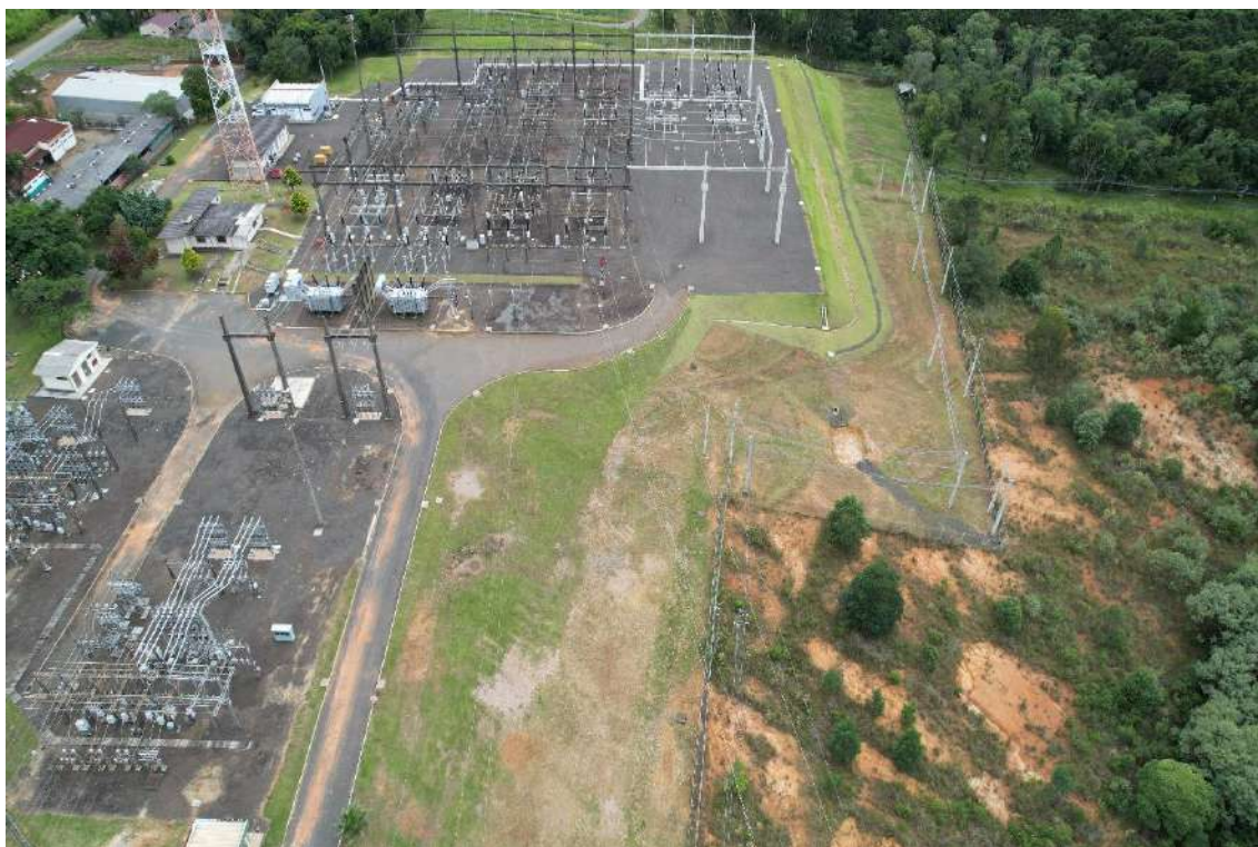
Figura 1.3.5. Vista aérea da Área Alvo 0002.
