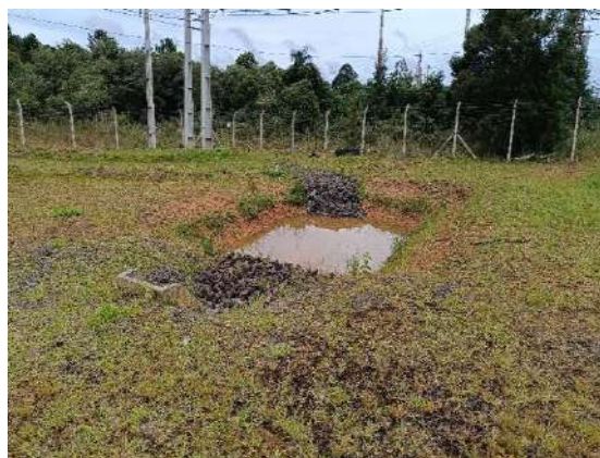
Figura 1.3.13. Vista dos dispositivos de controle de processo erosivo da área AA 0004 (setembro de 2023).
