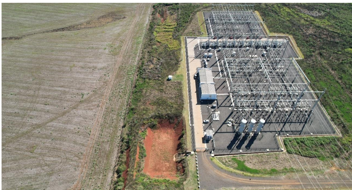
Figura 1.3.11. Vista aérea da Área Alvo 0004.
