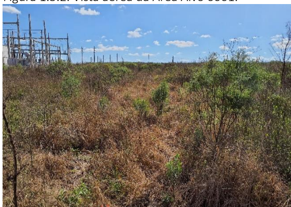
Figura 1.3.3. Vista da área AA 0001 (junho de 2023).
