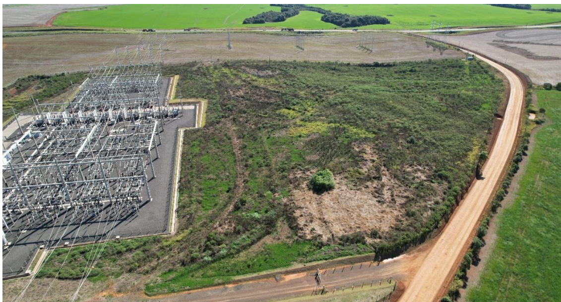
Figura 1.3.5. Vista aérea da Área Alvo 0002.
