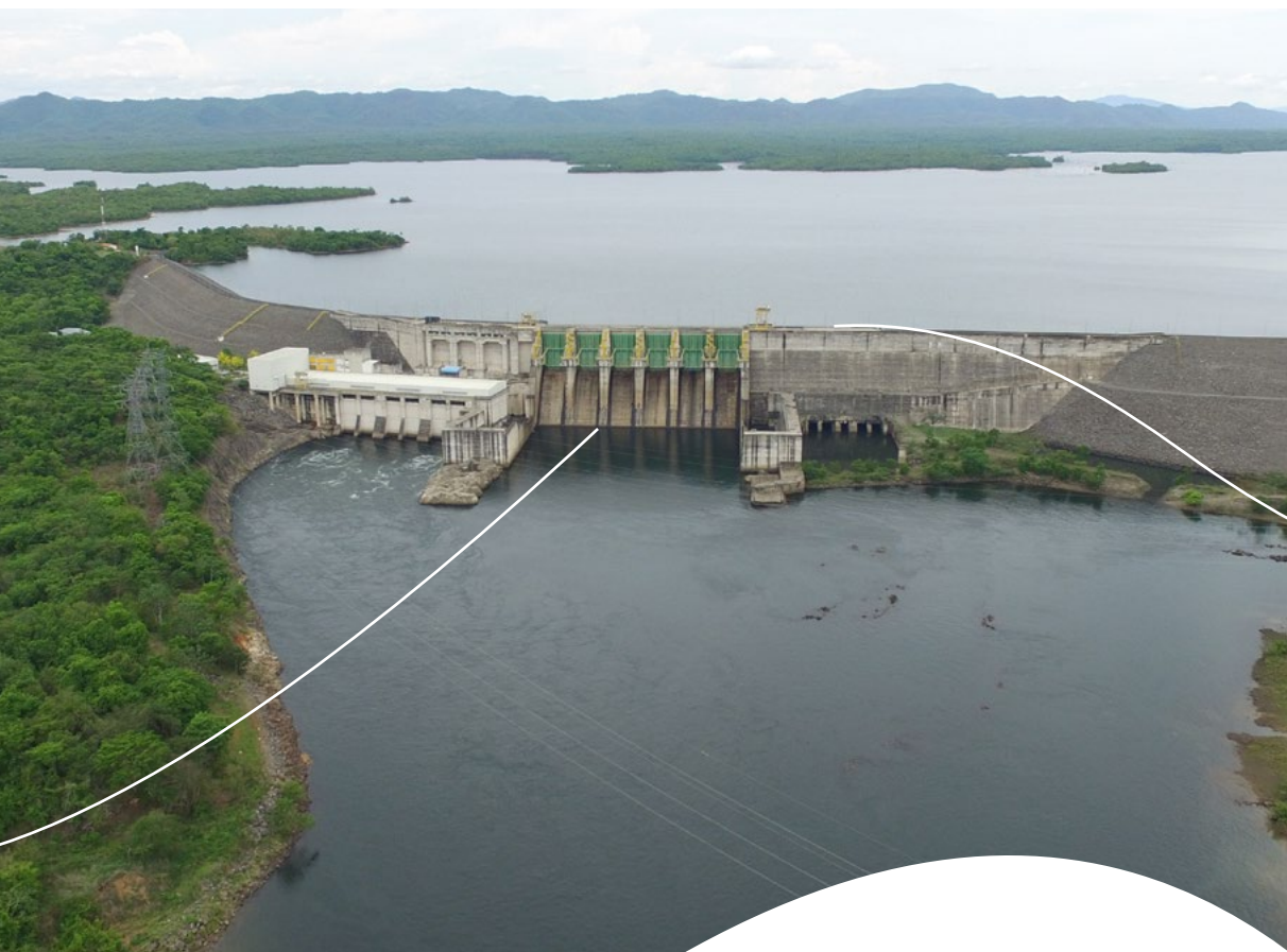
Usina Hidrelétrica Cana Brava
